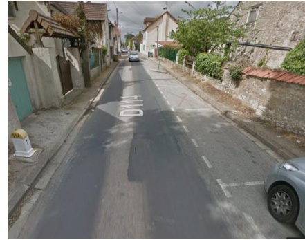
Inconfort de la traverse de la RD 114
