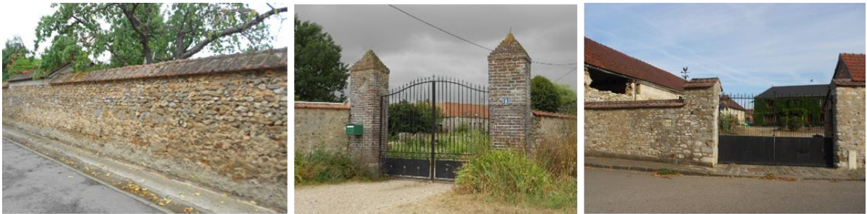
Les murs d'enceinte et les entrées de propriétés participent à l'identité du territoire
