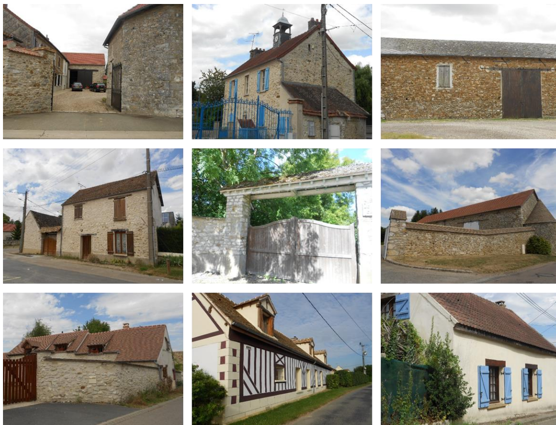
Une unité forte dans le bâti ancien du fait de l'emploi de matériaux peu nombreux
