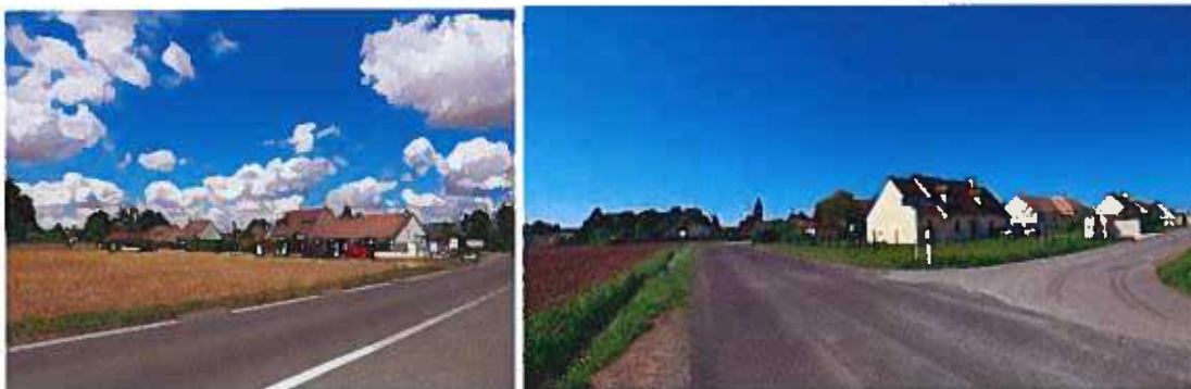
Manque d'intégration paysagère des quartiers récents à Neauphlette et à Lommoye
