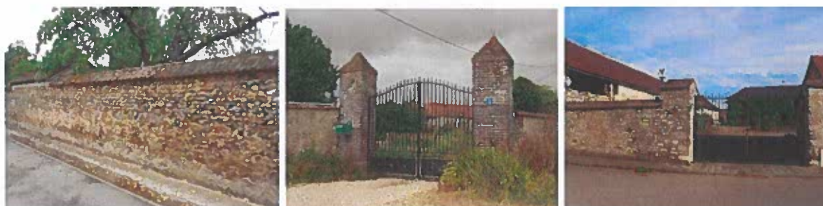
Les murs d'enceinte et les entrées de propriétés participent à l'identité du territoire
