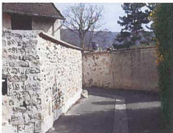
Qualité des murs à Moisson
